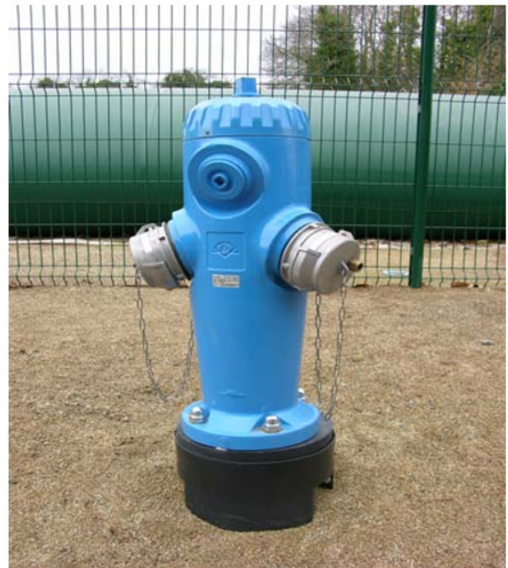
Poteau d'aspiration de 150 mm, muni de deux sorties de 100 mm et d'un carré de manœuvre.
