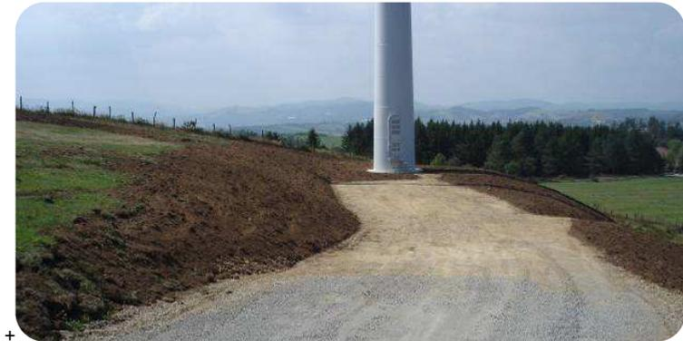
Figure 5 : Plateforme de levage restaurée en fin de chantier © VALECO
