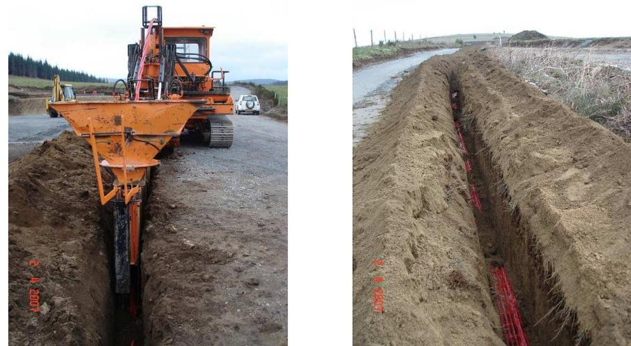
Figure 11 : Réalisation en simultanée de la tranchée et de la pose du câble
