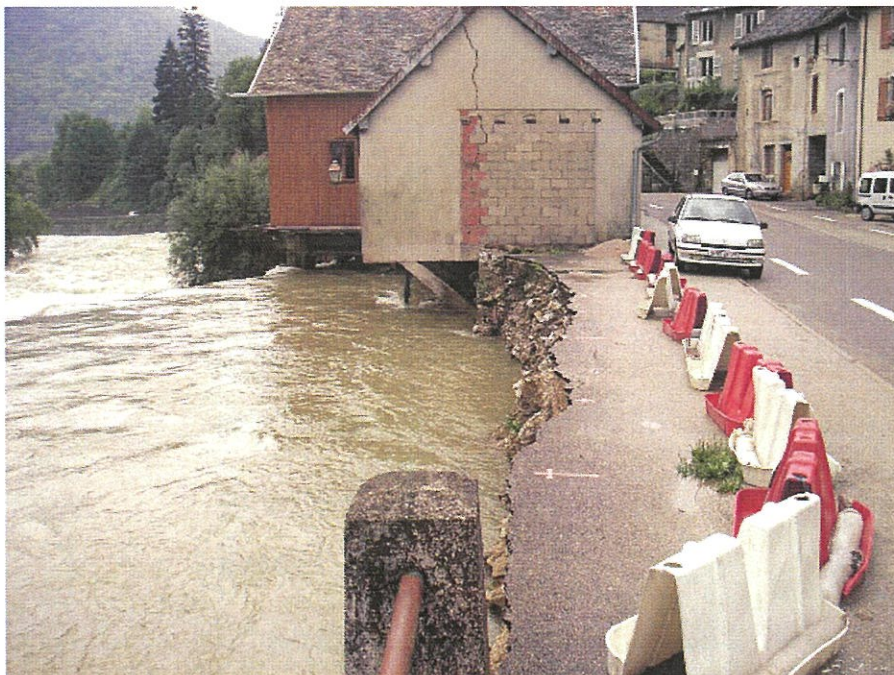
Illustration 18: Érosion de berges à Lods (25) - 2006 (Source DLA)
