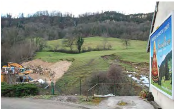
Exemple de glissement de terrain à Salins-les-Bains (39) (photo BRGM).
