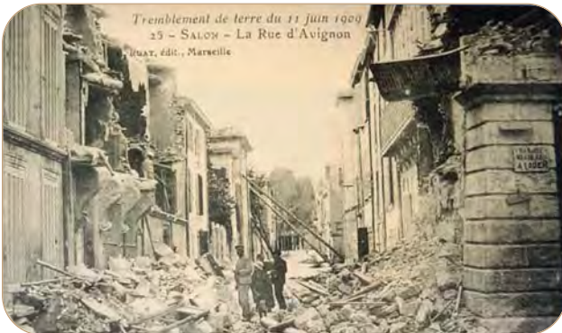
Dommages aux habitations suite au séisme de 1909 à Salon-de-Provence (département des Bouches-du-Rhône)
