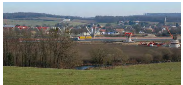
Configuration susceptible de créer un effet de site dans la plaine alluviale de la Savoureuse (90), avec le viaduc de la LGV Rhin-Rhône, dimensionné pour ce phénomène (photo BRGM).
