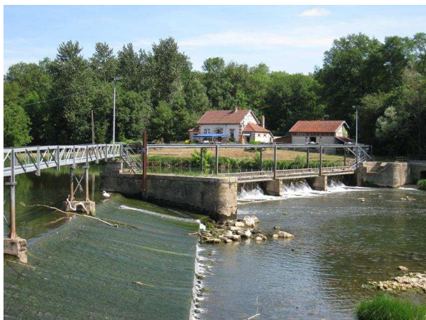
Le barrage vu depuis la rive droite.
